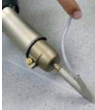
Сварка напольных покрытий ручным аппаратом TRIAC ST
